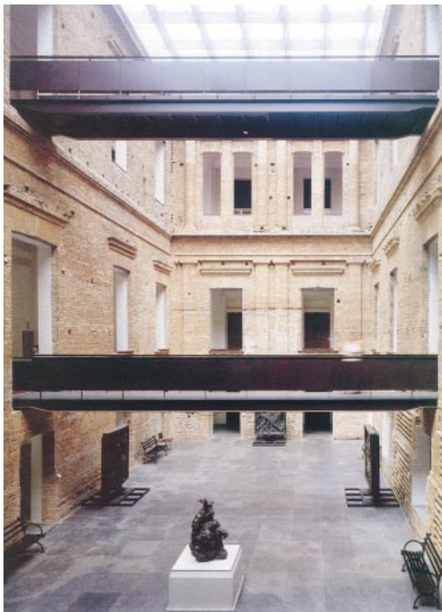
Remodelación del patio interior: con pasarelas y cubierta transparente.
